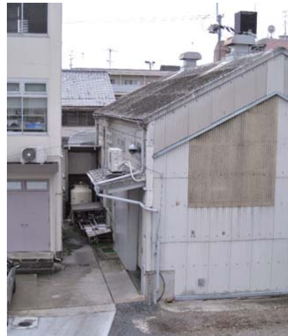
プラズマ窒化処理棟
